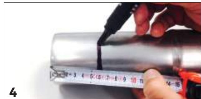
4 Marcatura quota d'innesto / Marking the insertion's depth
